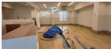
奥マンション二階に設置した厨房の土間排水施工中、オーク調シートで仕上げて厨房機器が入る直前。お仕事場でありながら温かみもある厨房になりました。
