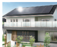
太陽光発電システム
